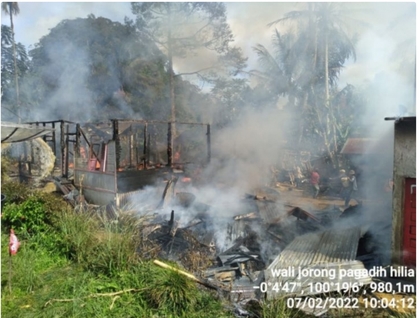
Kebakaran di Nagari Pagadih yang menghancurkan 3 buah rumah
